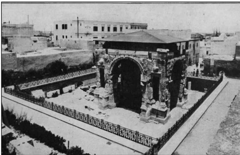
FIGURE 4: ARCH AFTER INITIAL RESTORATION, BOLLETTINO D'ARTE , 1926, 555. ROMA: DIREZIONE GENERALE ARCHEOLOGIA (AUTHORISATION No. 26754).
